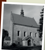
4) Celkový pohled na kostel od jihovýchodu.
