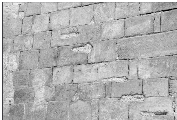
Obr. 24: Libčany (okr. Hradec Králové), kostel Nanebevzetí Panny Marie. Detail kapes po stupních schodiště na jihozápadním nároží kostela (foto M. Falta 2005).
