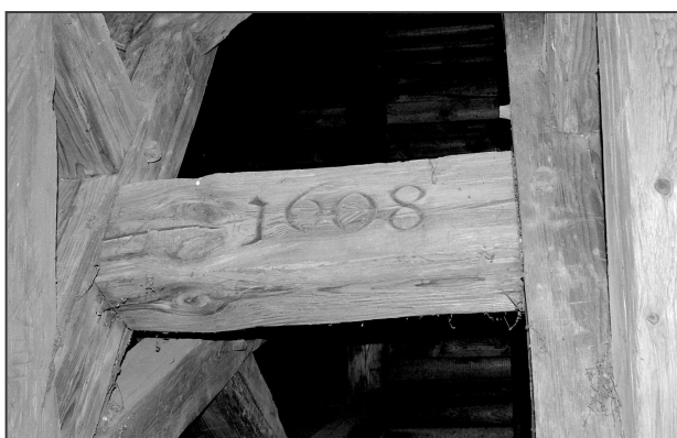
Obr. 20: Libčany (okr. Hradec Králové), kostel Nanebevzetí Panny Marie. Rytý letopočet datující konstrukci krovu (foto M. Falta 2006).
