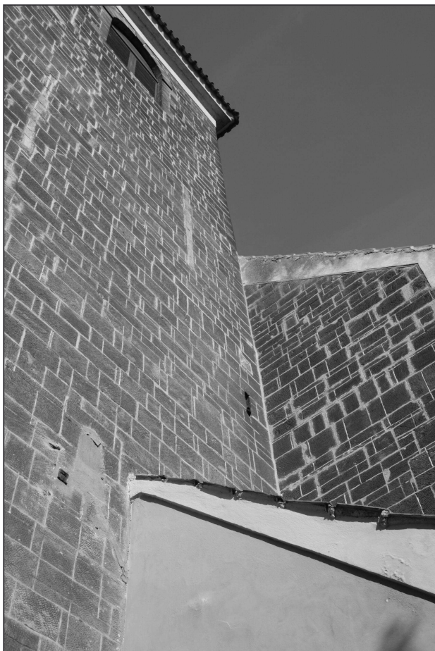
Obr. 3: Čelákovice (okr. Praha-východ), kostel Nanebevzetí Panny Marie. Pohled na jižní stěnu věže a západní štít kostelní lodi (foto M. Falta 2010).
