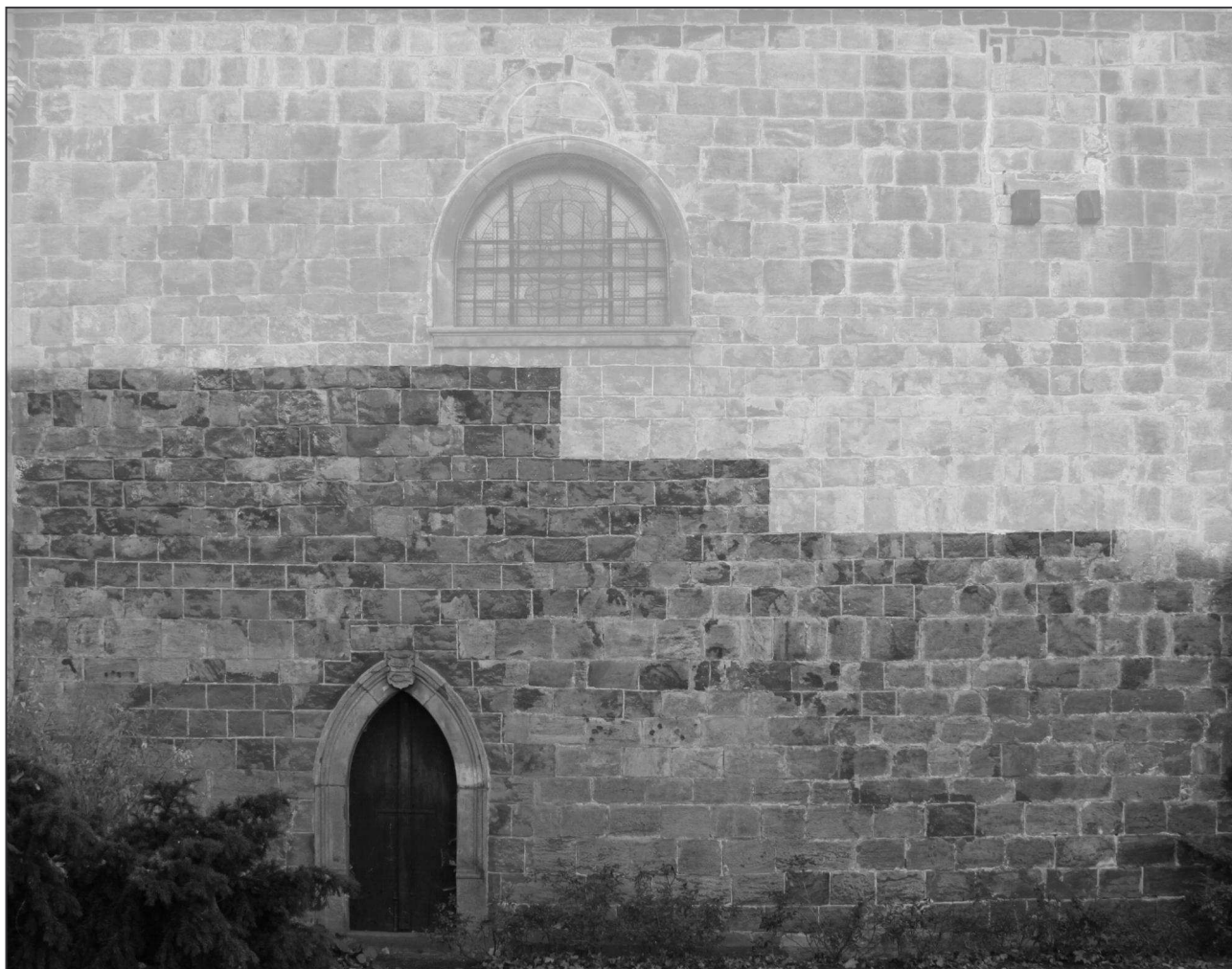
Obr. 18: Čelákovice (okr. Praha-východ), kostel Nanebevzetí Panny Marie. Fotografie severní fasády s vyznačením „schodovitého“ ukončení III. stavební fáze (foto M. Falta 2010).
