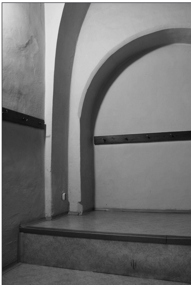
Obr. 12: Čelákovice (okr. Praha-východ), kostel Nanebevzetí Panny Marie. Odlehčující arkáda západní zdi lodi v úrovni empory (foto M. Falta 2010).
