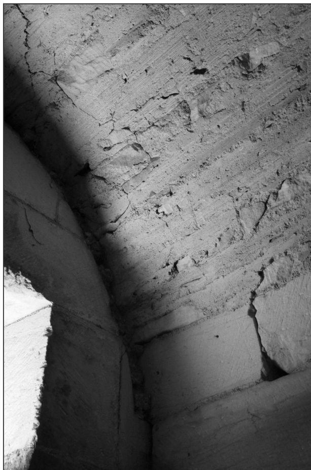
Obr. 9: Čelákovice (okr. Praha-východ), kostel Nanebevzetí Panny Marie. Detail klenby kobky v předpokládaném druhém románském patře věže (foto M. Falta 2010).
