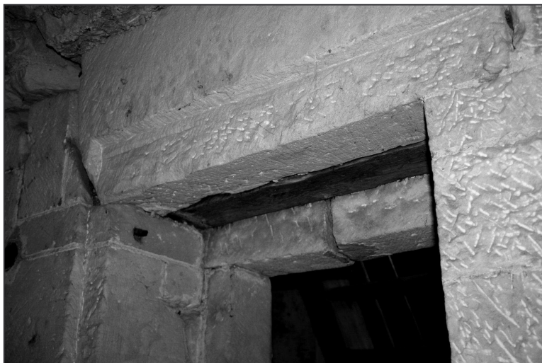
Obr. 10: Čelákovice (okr. Praha-východ), kostel Nanebevzetí Panny Marie. Detail nadpraží vstupu do kobky v předpokládaném druhém románském patře věže (foto M. Falta 2010).
